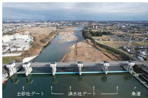
図-2 荒川・六堰頭首工(上流側から)
